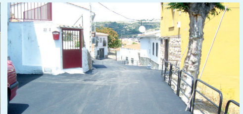
Detalle de asfaltado C/ Cuevas Altas
