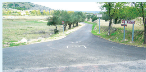
Detalle de asfaltado Vía Verde
