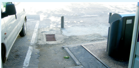
Instalación nueva rejilla zona Pl. de Don Arsenio
