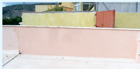
Reparación del muro, baldosas y rodapié
