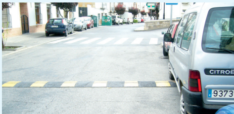
Asfaltado, paso de cebra y reductores de velocidad en la C/ Mayor Alta
