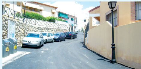
Detalle de asfaltado en C/ Cuesta Moyano
